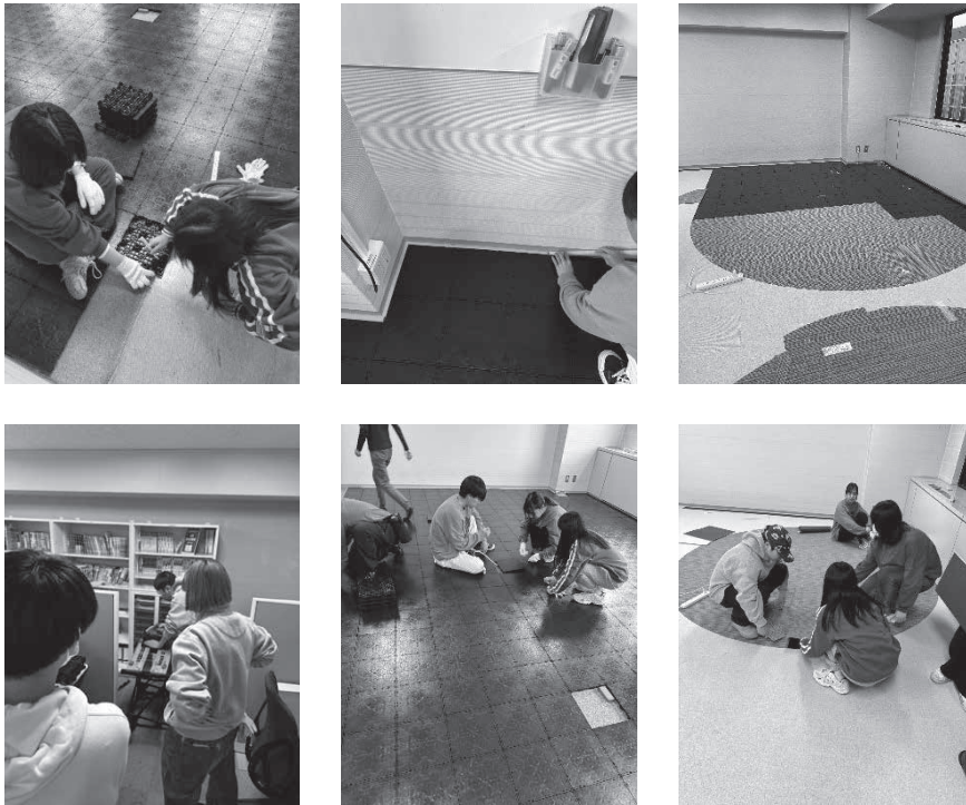
図 12 現場調整の様子：端部等、形状が不規則な部分で調整が必要になる
